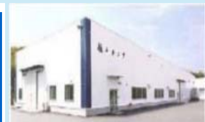
被災した工場・施設等の復旧支援
