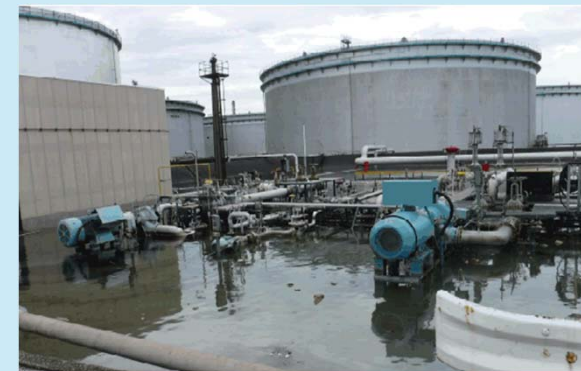
（製油所で発生した冠水被害）
